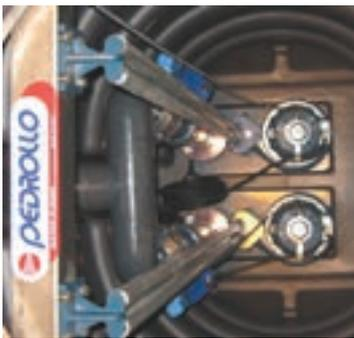
Etanchéité fond de cuve parfaite, montage des pieds d'assise sur platine PVC rapportée (pas de perçages en fond de cuve)
