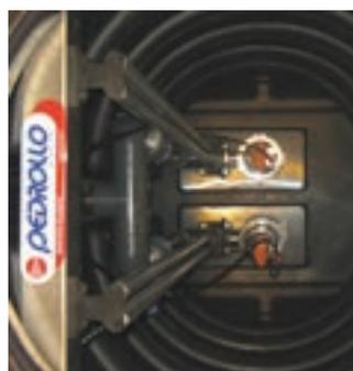
Etanchéité fond de cuve parfaite, montage des pieds d'assise sur platine PVC rapportée (pas de percages en fond de cuve)
